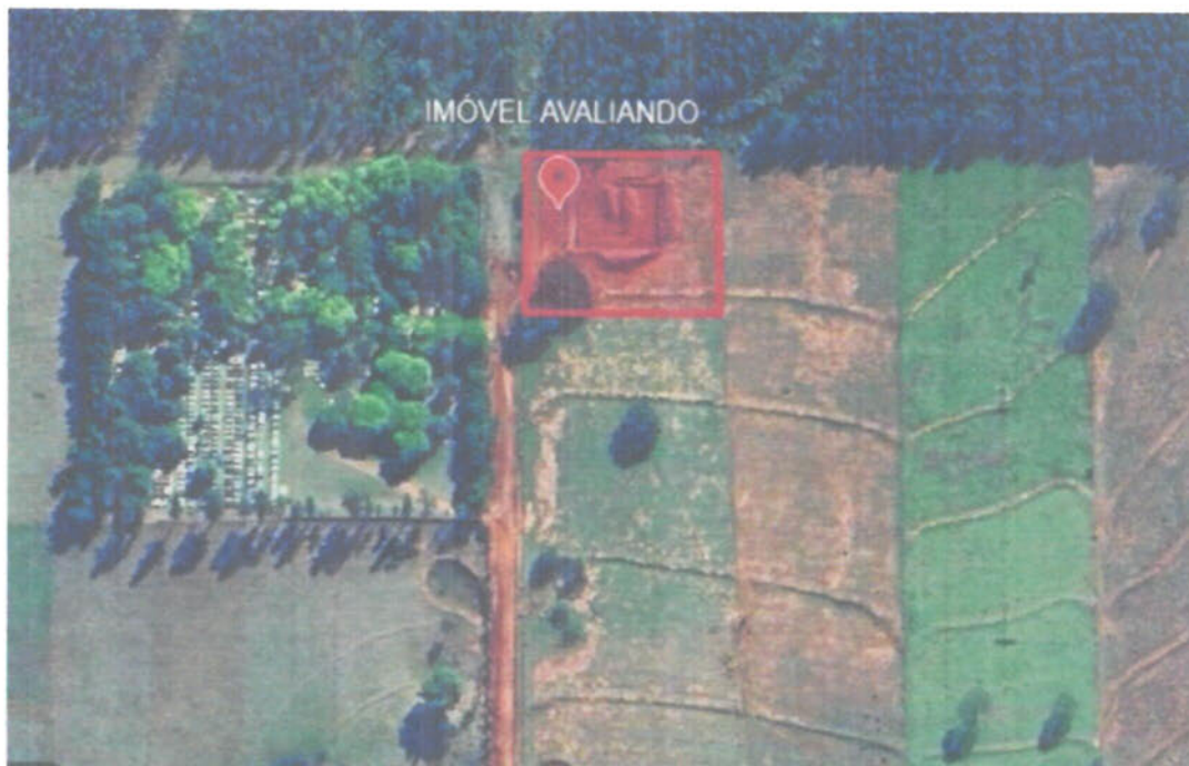
Imagem 03 – Localização do terreno do imóvel avaliando Fonte – Google Earth
