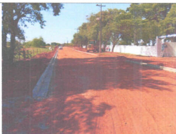
Foto 09 – Rua Maranhão em obras de pavimentação
