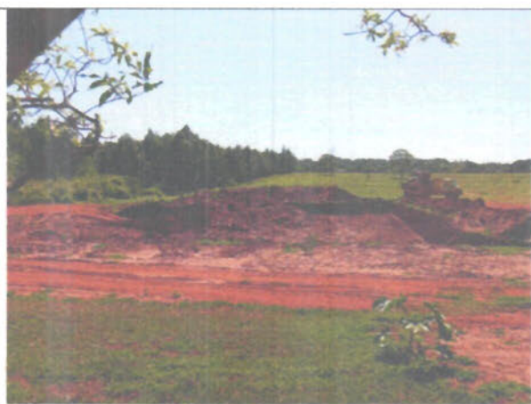
Foto 08 – Imóvel avaliando – vista frente
