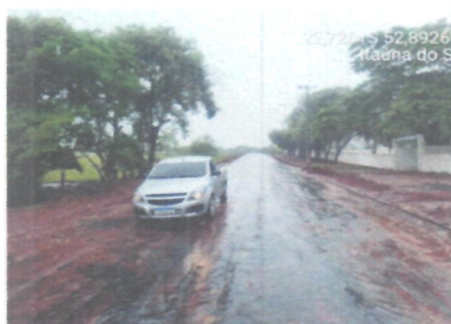
Vista da Rua
