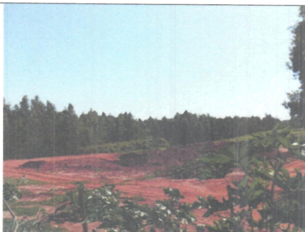
Foto 01 – Frente do imóvel vista da Rua Maranhão
