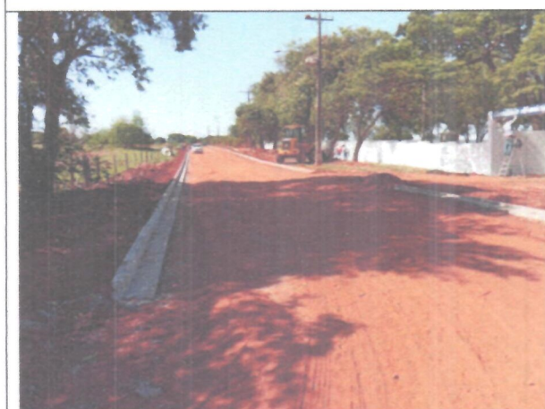
Foto 09 – Rua Maranhão em obras de pavimentação
