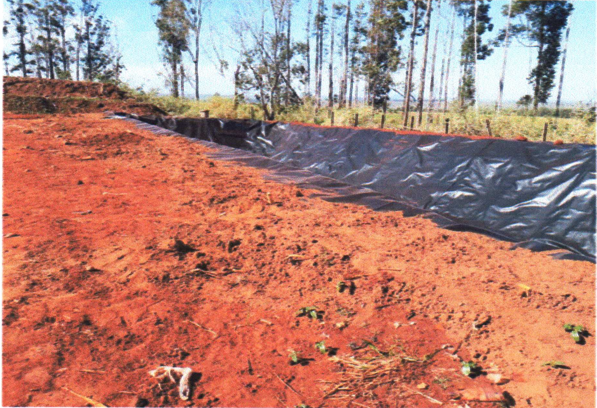
FOTO 5 - Trincheira Impermeabilizada do Aterro Sanitário
